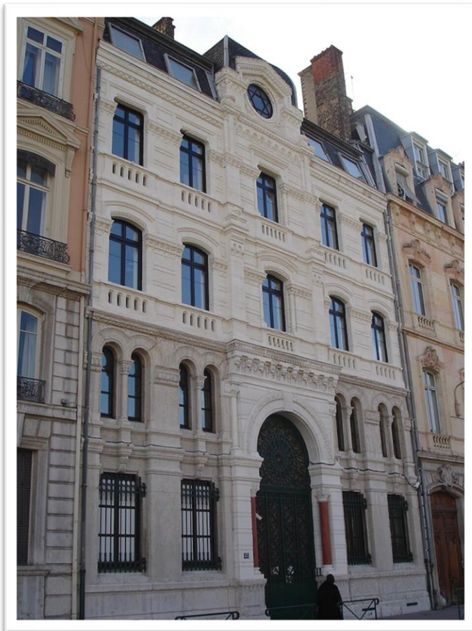
Façade sur le quai Tilsitt
