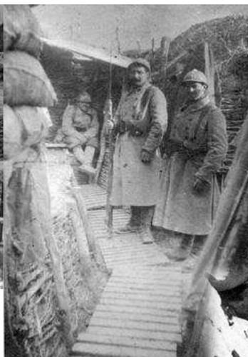
Régulièrement, des abris couverts dit "abris légers" sont aménagés, creusés sous plusieurs mètres de terre et renforcés de rondins et de poutres de bois afin de pouvoir résister à un bombardement de petits calibres.
