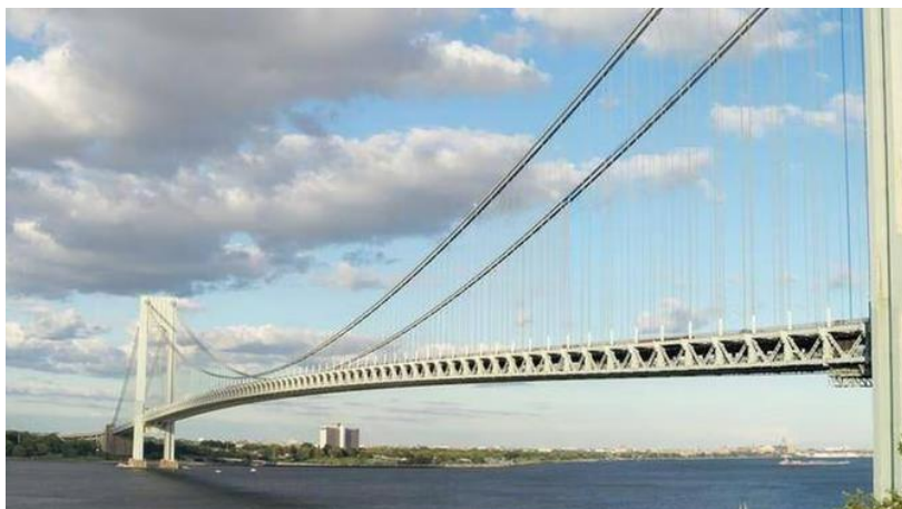
Le pont de Verrazano. (Photo : Ajay Suresh / Wikimedia Commons / CC BY 2.0)
