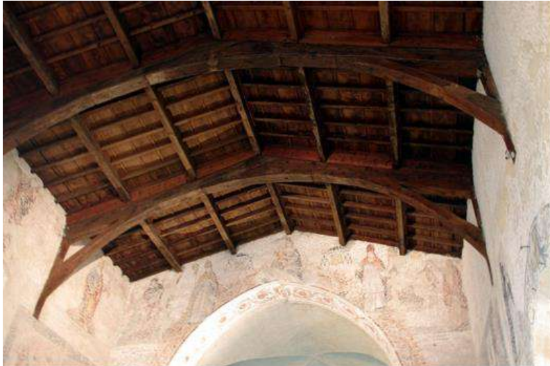
Charpente de la chapelle en carène de bateau renversée
