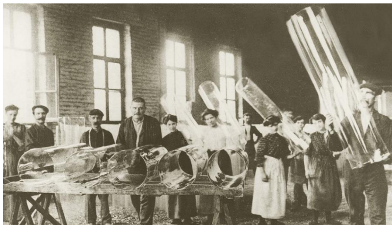
Soufflage de verre à vitres au canon - 1920
