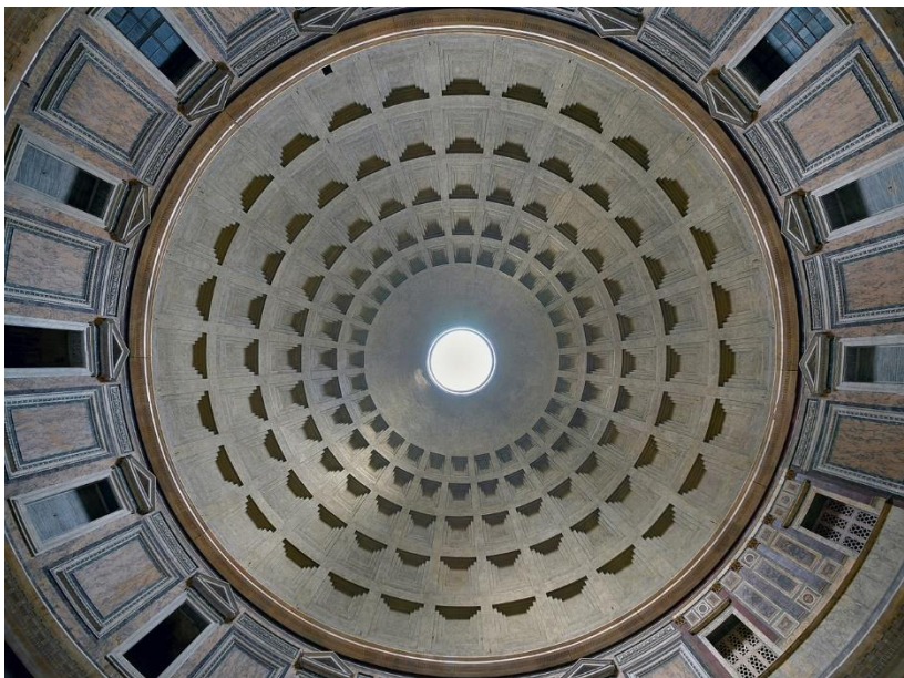
Oculus percé dans la coupole du Panthéon de Rome L'ouverture n'est pas protégée, si bien que la pluie peut tomber à l'intérieur de l'édifice.
