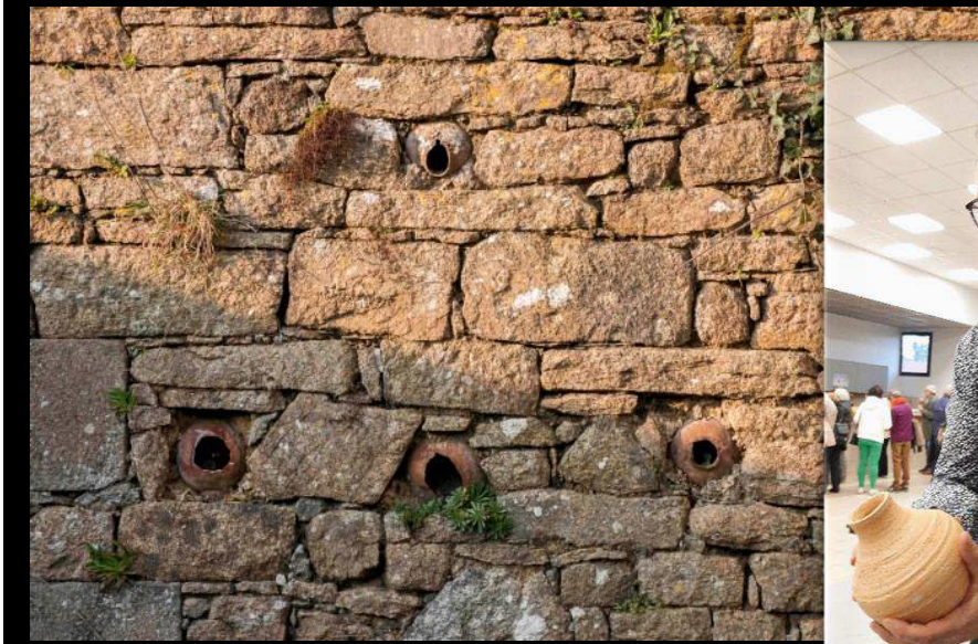
Pots mis en œuvre au moment de la construction des murs : étude du bâti
