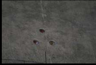
Saint-Chef-en-Dauphiné, Isère Pots acoustiques insérés dans les murs de la nef
