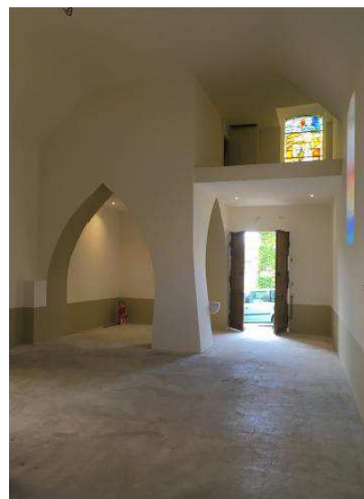
Entrée de l'église vue de l'intérieur après travaux de 2016 Le pilier d'appui du clocher, la tribune
