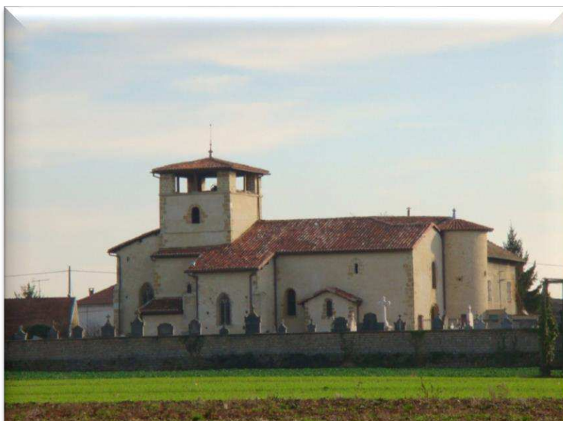
Façade Nord de l'église, vue depuis le cimetière
